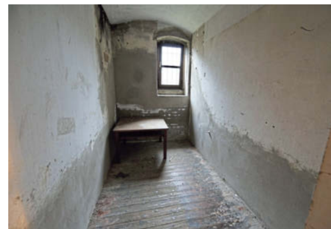
Nicht sehr einladend: So sieht es in den ehemaligen Zellen im alten Amtshaus Ennigloh aus. FOTOS: GERALD DUNKEL
